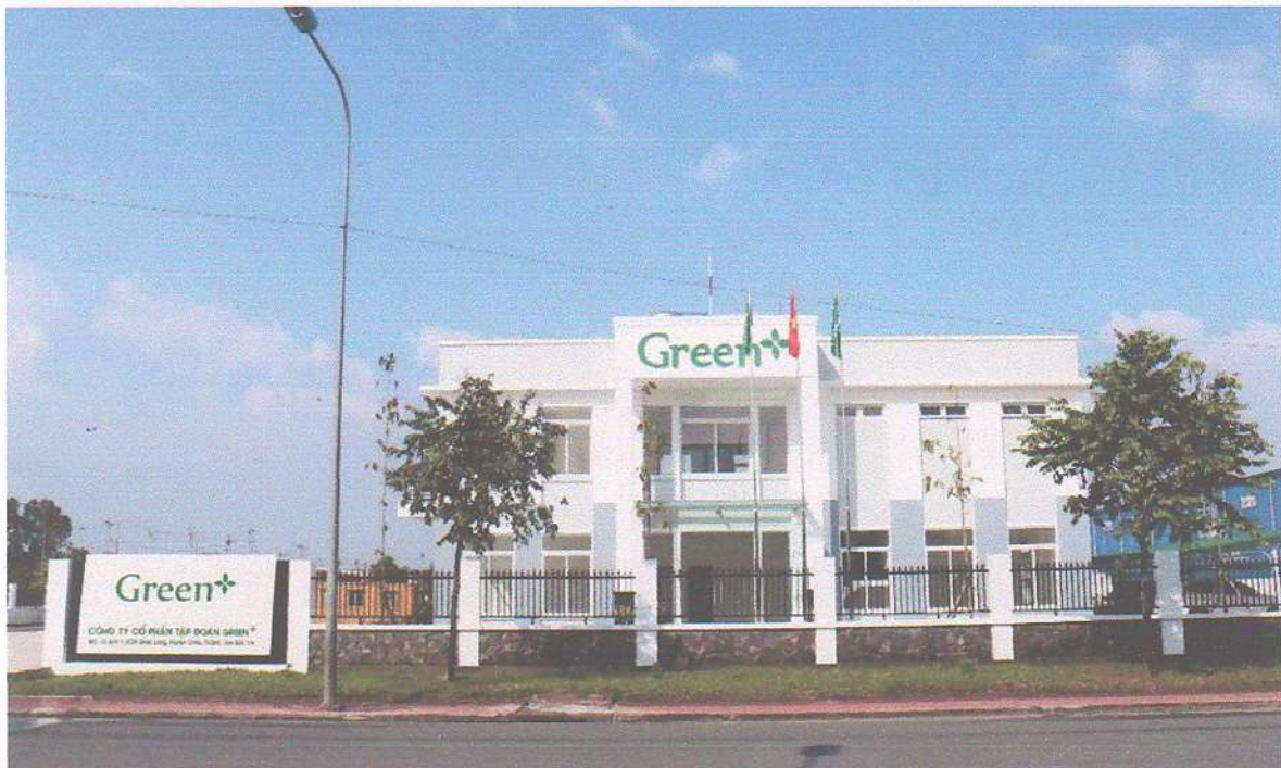
Nhà Máy Sản Xuất Thực Phẩm Chức Năng Green+ đang xây dựng
