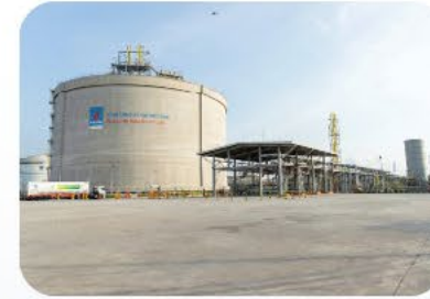
Hệ thống bồn chứa
