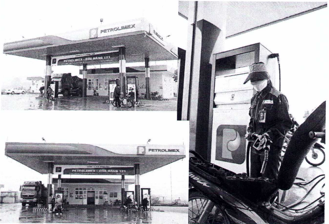
Một số hình ảnh Cửa hàng bán lẻ xăng dầu của PTS Nghệ Tĩnh
