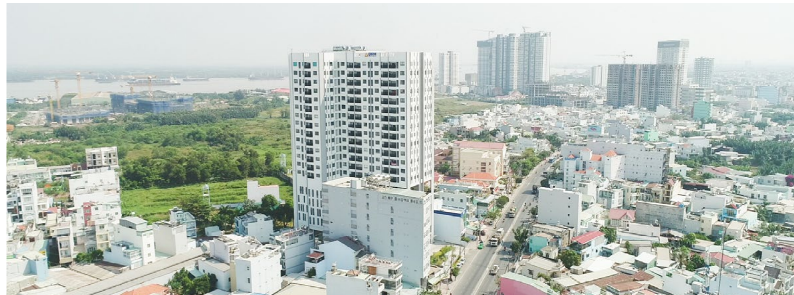
Hình thực tế dự án D-Vela tại Huỳnh Tấn Phát, Quận 7
