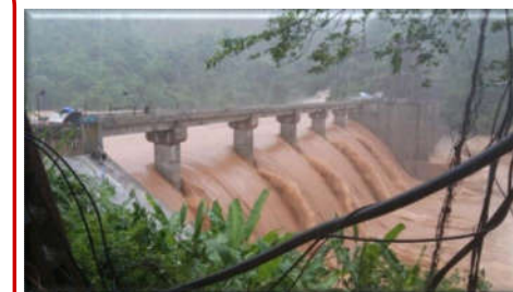
Nước lũ trên sông Đăkrông dâng cao vượt đập tràn tự do
