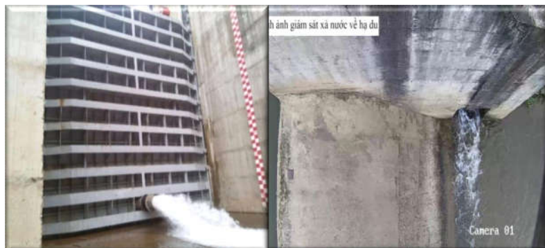
Đảm bảo dòng môi trường cho hạ lưu đập NMTĐ Đa Krông 1
