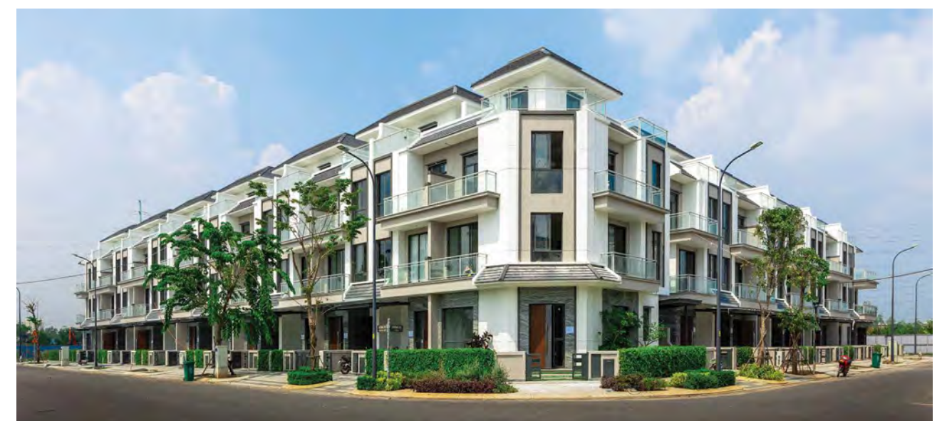
Công trường xây dựng dự án Khu nhà ở Bình Trưng Đông 1 và Bình Trưng Đông 2
