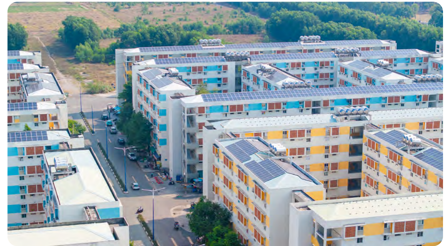
Một khối nhà tiêu chuẩn trong khu nhà ở xã hội Định Hòa
