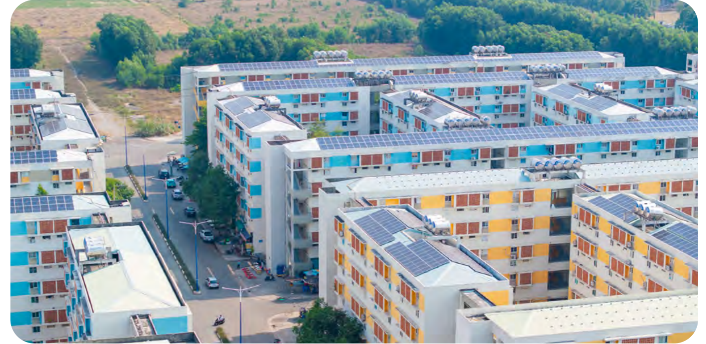
Lắp đặt điện mặt trời áp mái tại các tòa nhà nhà ở xã hội Định Hòa
