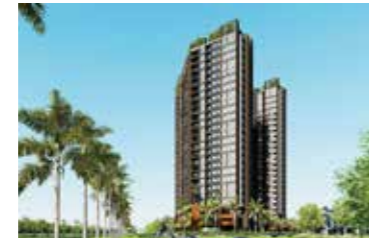
Parc Ville Social Housing Project
