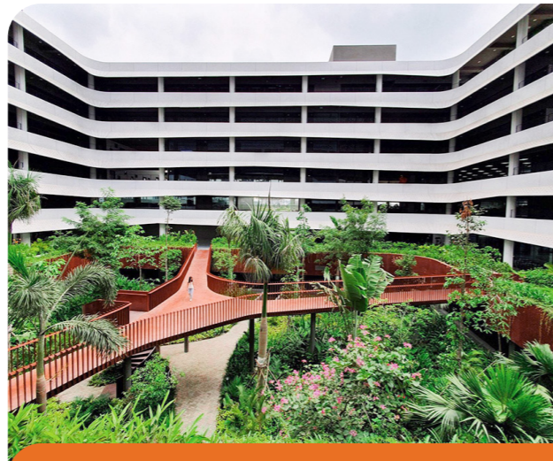
F-Town 3 được Wallpaper – tạp chí hàng đầu của Anh về kiến trúc và thiết kế xếp vào nhóm công trình tiêu biểu cho kiến trúc sinh khí hậu (bioclimatic), trong đó hơn 40% không gian không cần sử dụng điều hòa.
