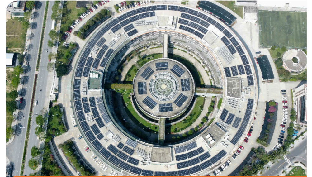
Hệ thống điện mặt trời mái nhà tại tòa nhà F-Complex (Đà Nẵng).
