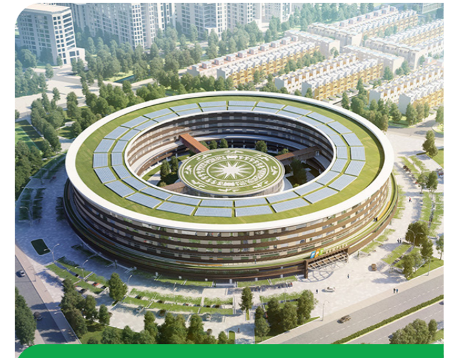
FPT Complex Đà Nẵng là công trình đầu tiên tại Việt Nam đạt chứng chỉ EDGE nhờ các giải pháp tiết kiệm năng lượng, thu hồi nước mưa, xử lý nước thải và hệ thống điều hòa, chiếu sáng hiệu suất cao.
